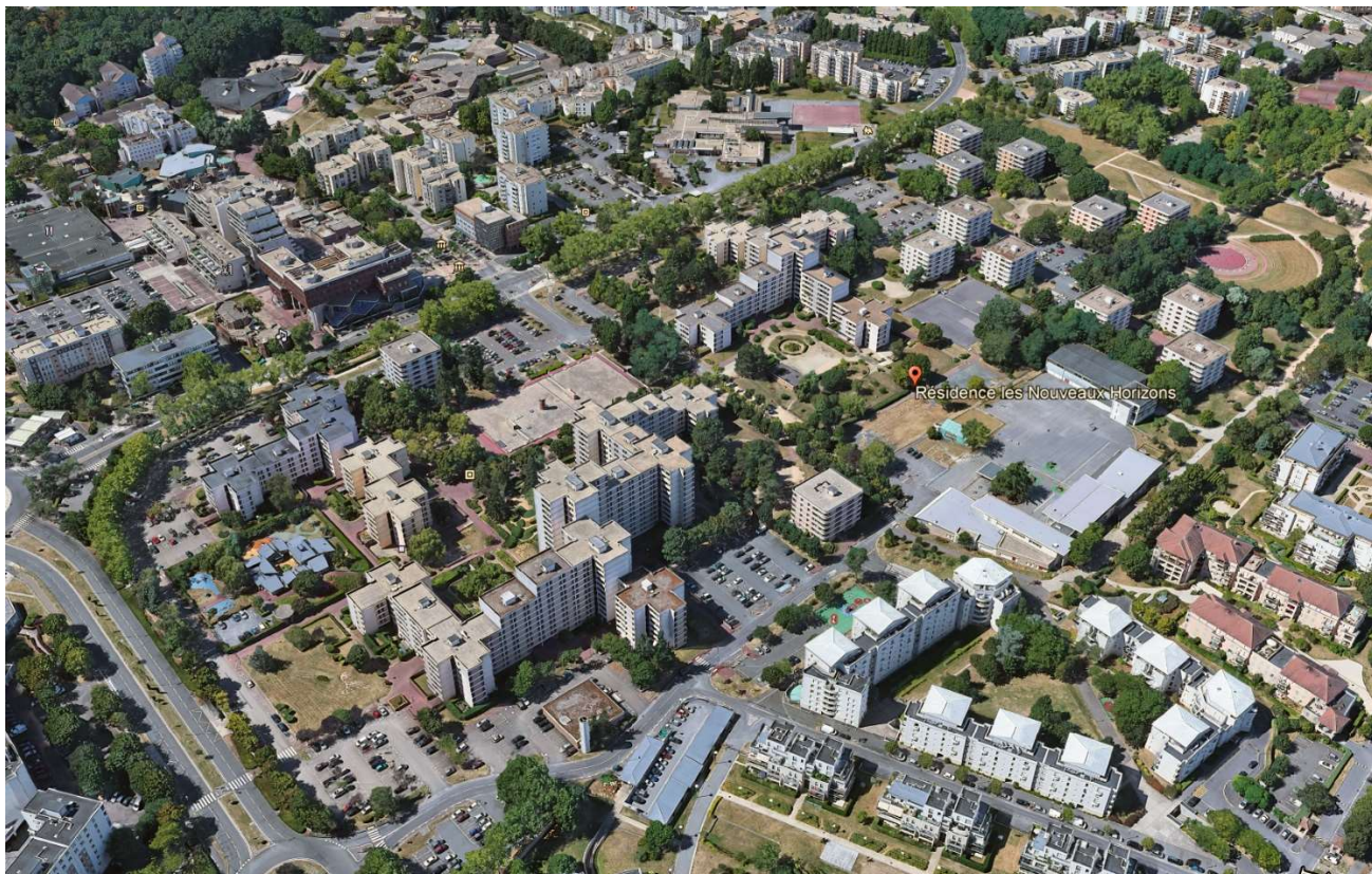
La Résidence « Nouveaux Horizons » aujourd'hui vue du ciel par le sud-est
