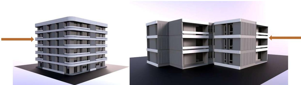
Ces éléments panneaux de béton préfabriqué filant sur l'ensemble des façades des bâtiments et créent ainsi une unité formelle pour identifier un bâtiment ou un groupe de bâtiments (sous-syndicat).
